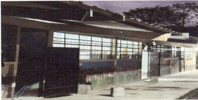
Foto 3: se le dio mantenimiento a las 5 puertas
