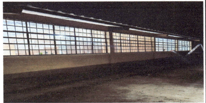
Foto 4: se instalaron los valcones para resguardar mobiliario y equipo del centro educativo tambien se colocaron algunos vidrios que se encontraban quebrados.
