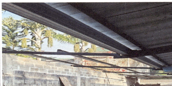
Foto 8: se concluyo la instalacion de bajadas de agua pluvial en el entechado del frente de las aulas.
