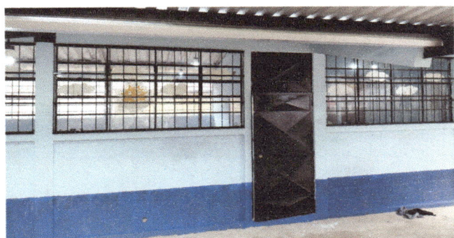
Foto 9: se concluyo el matenimiento de las paredes de las aulas pintandolas por dentro y por fuera.
