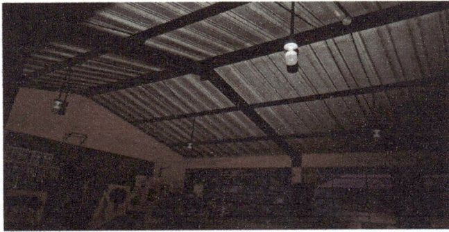
Foto 1: sistema electrico instalado con mejorar la iluminacion en las aulas
