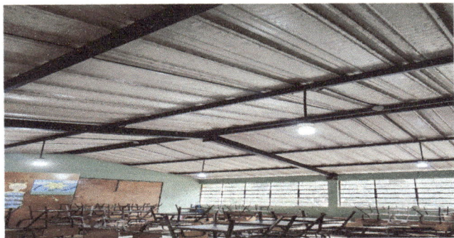
Foto 7: se completo el mantenimiento de costaneras del techo en las 3 aulas, dando un ambiente agradable para los niños.
